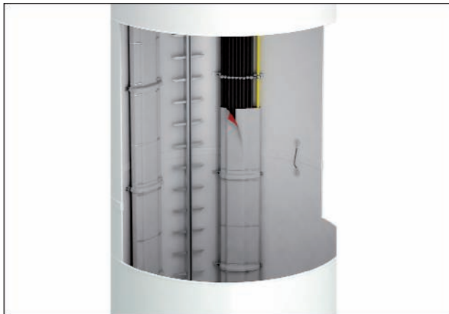
Bandaazitud püsttrass tuulegeneraatori tornis
