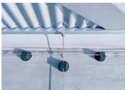
Metalfassaadi ühendamine piksekaitsesüsteemiga
