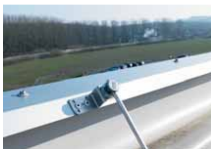
Parapeti ühendamine piksekaitsesüsteemiga
