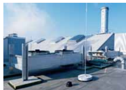
Isoleeritud piksekaitse katusepaigaldistel
